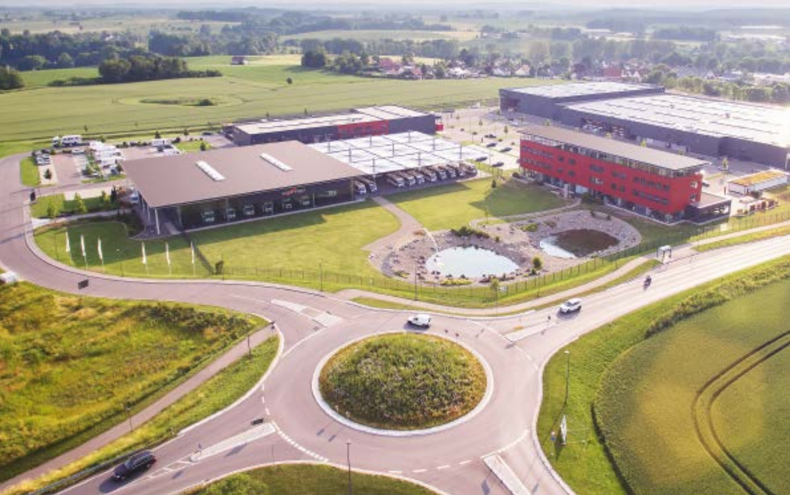
▲ Centrale d'entreprise Carthago à Aulendorf
