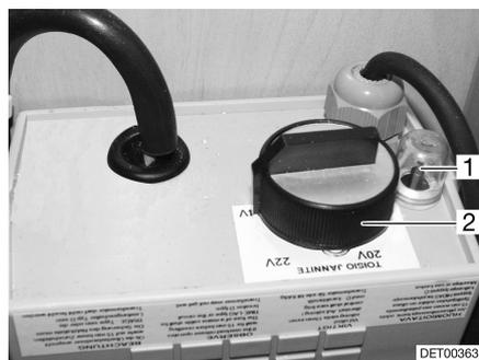
Fig. 69 Régulateur du chauffage électrique du plancher
