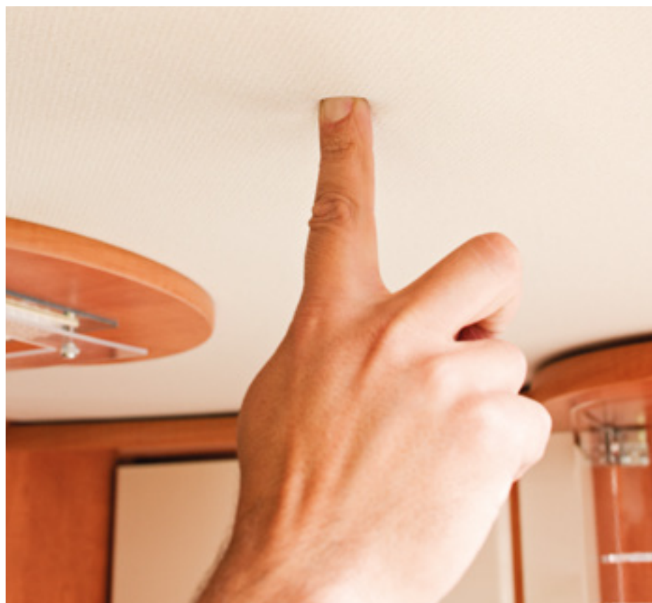
MOUSSE ISOLANTE AU PLAFOND
